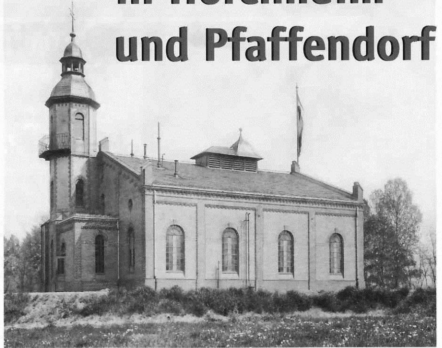
Pumpwerk II des städtischen Wasserwerks auf dem Oberwerth nach der Erweiterung 1904.
