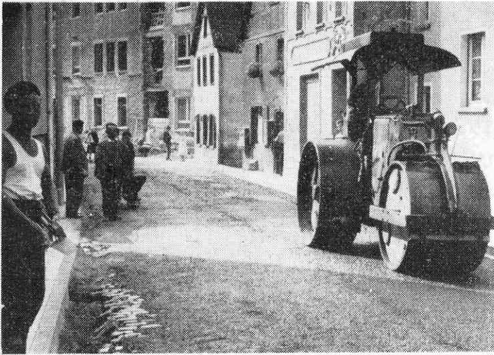
Oben: Ein lang ersehnter Wunsch ging in Erfüllung: Horchheim erhielt ein neues Straßenbild. Das alte längst ausgediente Pflaster der Emser Straße verschwand unter einer glatten Asphaltdecke.
