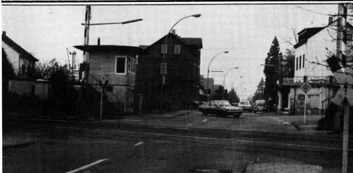
Am Bahnübergang Emser Straße sorgt modernste Technik für Sicherheit.
