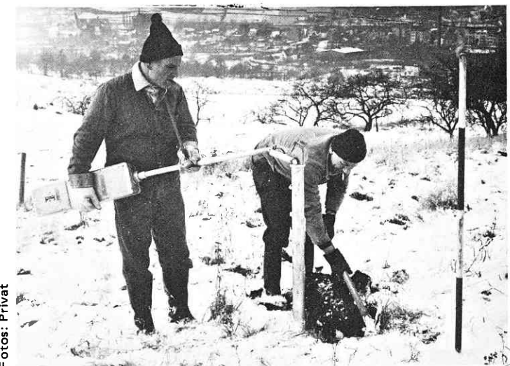
Kein Staubsauger, sondern die Förster-Sonde, die Wünschelrute der Feuerwerker. Rechts im Bild Johann Becker.
