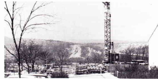
Nach langjährigem Warten wurde endlich mit dem Bau des neuen Kindergartens auf der Horchheimer-Höhe begonnen.
