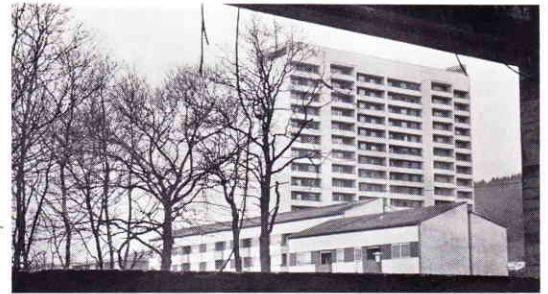
Wie an vielen Baustellen im Koblenzer Raum, so trieb auch auf der Horchheimer - Höhe der „Bau-Klau“ beim Bau des neuen Gemeindezentrums sein Unwesen.
