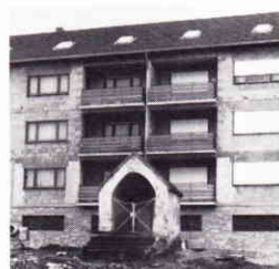
Das Heiligenhäuschen - im derzeitigen Zustand kein Glanzpunkt für Horchheim.
