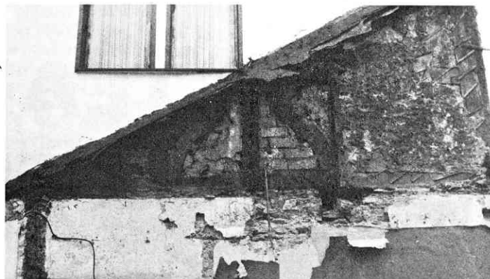
Durch den Abriß des Schuppens wurde das historische Fachwerk freigelegt.
