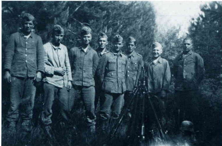
Ruhepause beim Bau eines zweiten Grabens, Juni 1943. 3.v.l.: Heinrich Fischer
