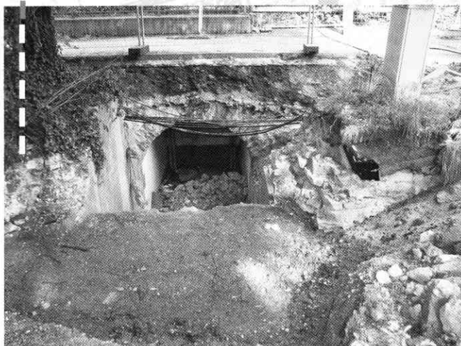
Rest der alten Bahnstättunterführung in der Von-Eyß-Straße
