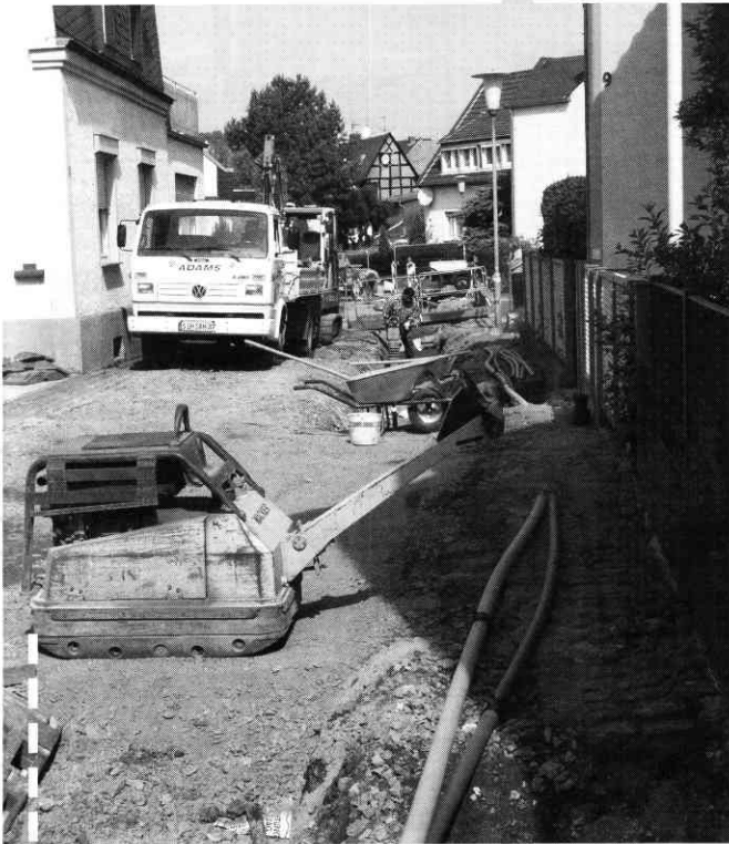
Kanalverlegung in der Bornsgasse
