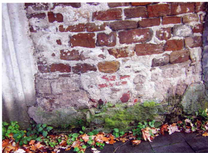
Abb. 1: Fundament des Turmes aus dem 19. Jahrhundert mit deutlich unterschiedlichen Mauertechniken
